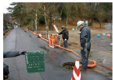
水替工の様子(最長作業エリア) 現場に応じて、最大300mまで水替え可能
