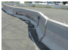
終点側から見た状況
