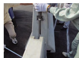
連結筋挿入状況
