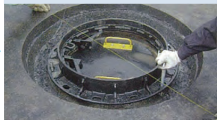
枠をセットし高さ調整をしボルト緊結
