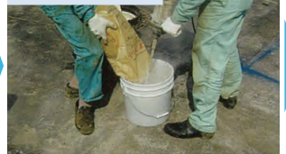
超速硬モルタル混練
