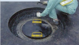
アンカー打ち込み
