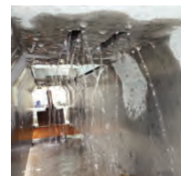
側溝内への排水状況
