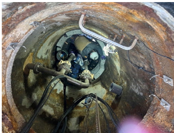
老朽化したマンホールに『バイセグ』を貼りつける工程
