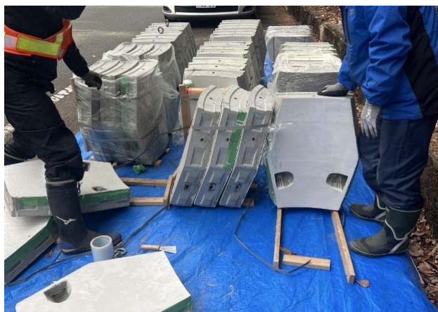
老朽化したマンホールを補強するために開発した『バイセグ』
