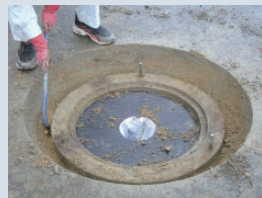
③鉄蓋及び土砂除去作業 切断完了後、鉄蓋及びマンホール周辺の土砂を除去します。
