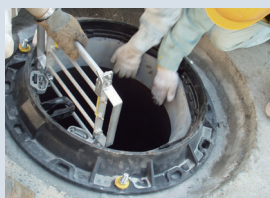
⑤内型枠装着 調整部内面に内型枠を曲げながら挿入し、内周に密着させます。
