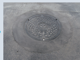
⑧完成 硬化後、周辺を清掃して完了です。
