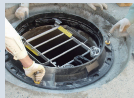
④受枠設置作業 受枠を設置し、路面の高さに合わせてレベルを調整します。
