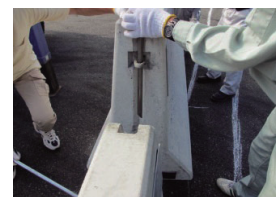
連結筋挿入状況
