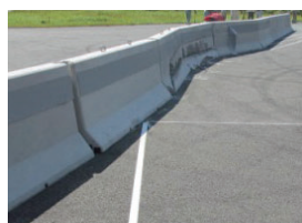
衝突地点から見た状況
