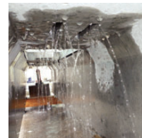
側溝内への排水状況
