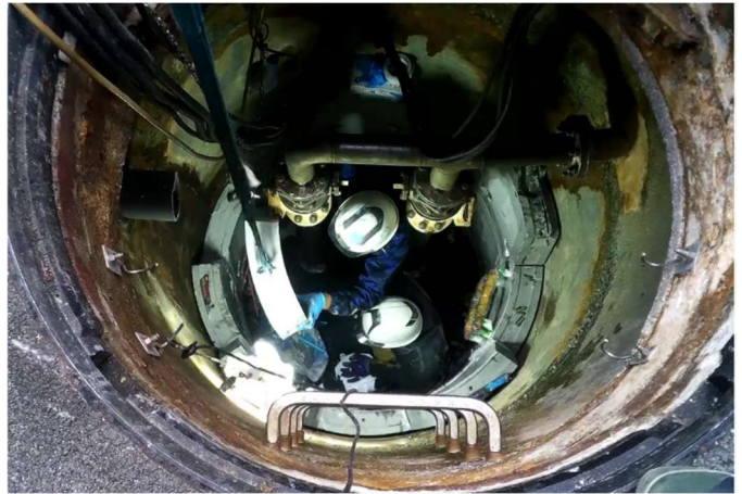
老朽化するマンホールに『バイセグ』を施工する作業風景
